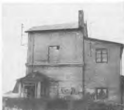
Ehem. optische Telegraphenstation Oberzündorf (Nordseite)
