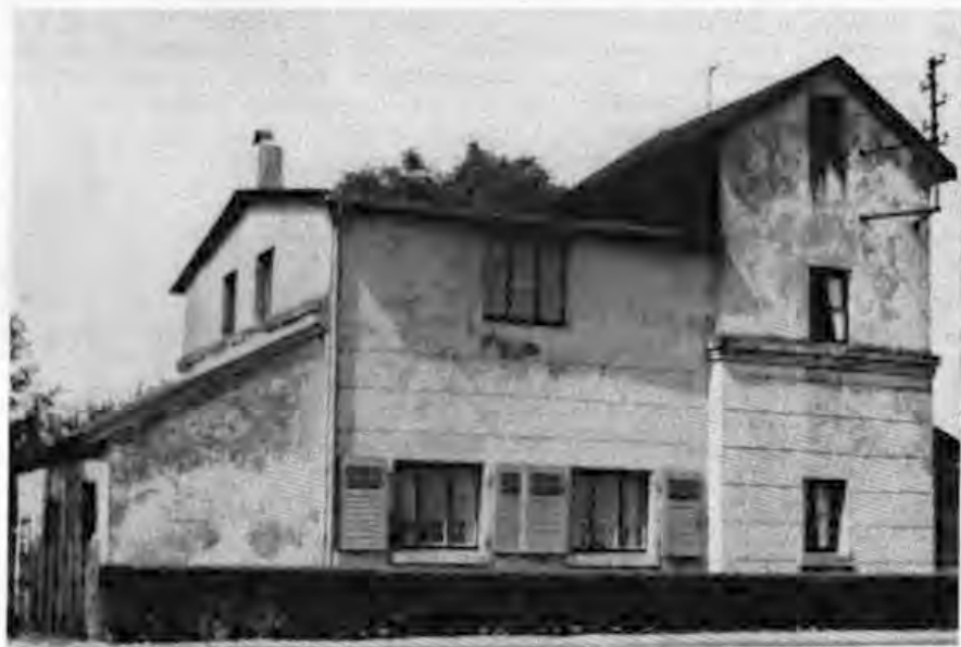
Das Gebäude des ehem. optischen Telegraphen bei Oberzündorf (Südostseite)
